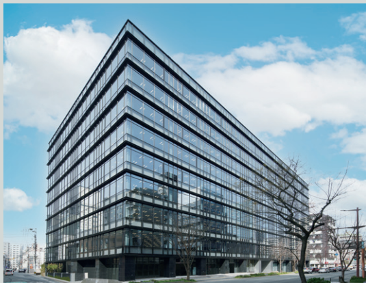
地上9階建て、延床面積2万561.08㎡。オフィスフロアの基準階面積は1,836.86㎡(555.65坪)
